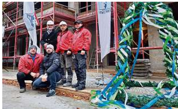
Vor dem traditionellen Richtspruch: Polier Olaf Trummer (hinten links) und sein Team vor dem Neubau. Fotos: Ulrike Kiefert
