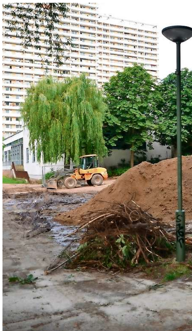
Der Bereich neben der Schwimmhalle Helene-Weigel-Platz ist bis Dezember abgesperrt. An dieser Stelle wird ein barrierefreier Zugang zum Springfuhlpark mit Serpentin angelegt. Foto: Philipp Hartmann
