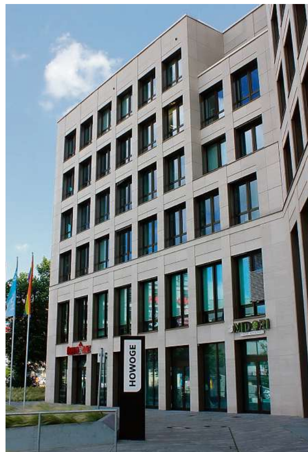
Das Neubauquartier der Howoge an der Frankfurter Allee. Hier befindet sich auch die Unternehmenszentrale. Foto: Bernd Wähler
